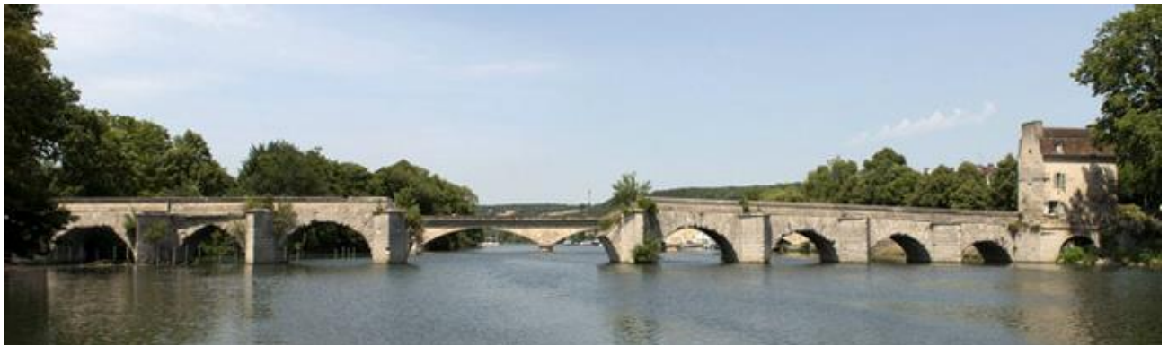
Vue du vieux pont de Limay depuis l'amont (le pont neuf en aval est visible dans la brèche)
